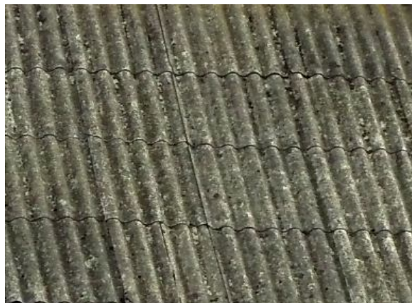
Rys. nr 1. Wyroby azbestowo – cementowe: po lewej najpowszechniej stosowane płyty faliste, po prawej płyty płaskie tzw. „Karo”.
