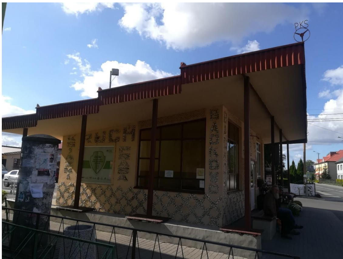
Budynek dworca autobusowego – widok od strony wschodniej (stan na dzień 10.09.2020).
