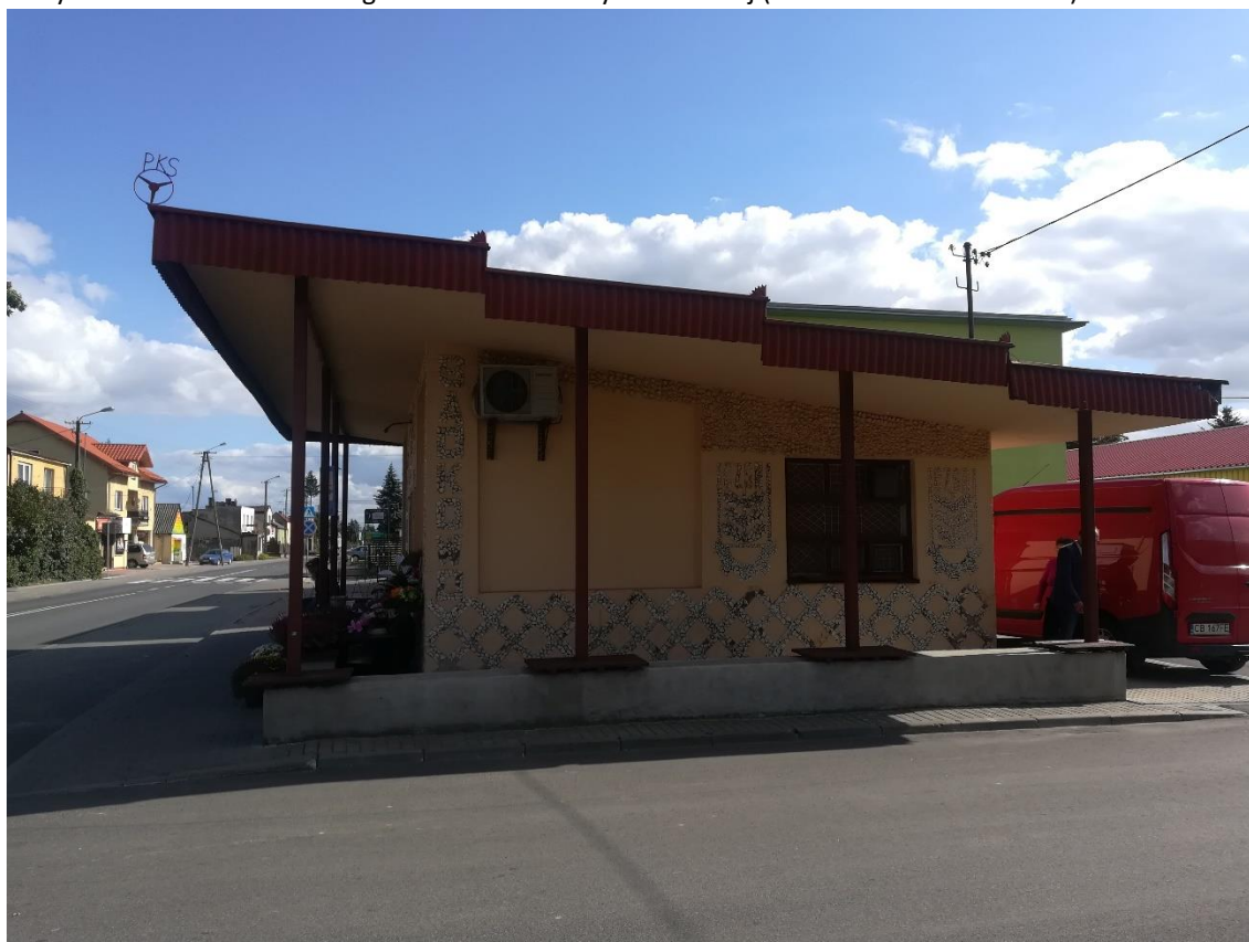
Budynek dworca autobusowego – widok od strony zachodniej (stan na dzień 10.09.2020).
