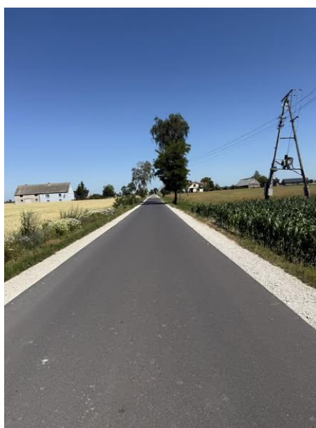
Remont poboczy przy drodze gminnej Jaranowo Duże – Toporzyszczewo
